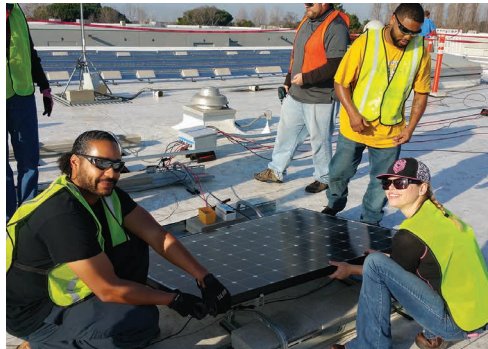
Teamwork voor een dakinstallatie
